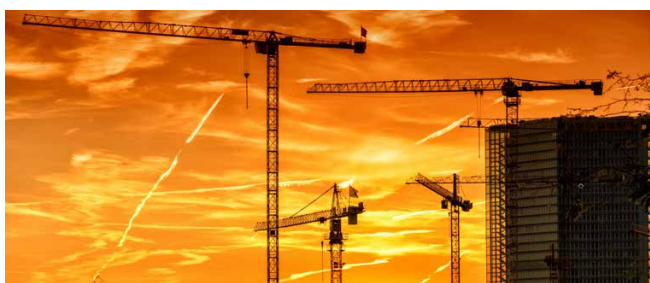
Replanteo en Construcción
